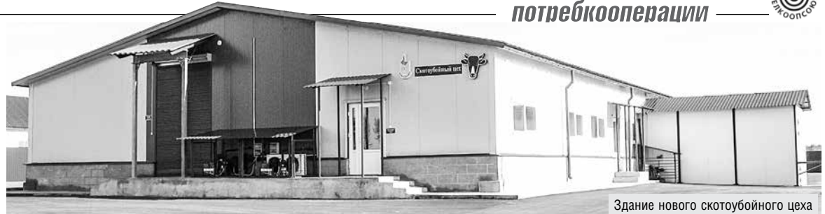
Здание нового скотобойного цеха
