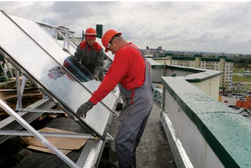
Устаноўка сонечных калектараў на даху энергаэфектыўнага дома ў Магілёве
